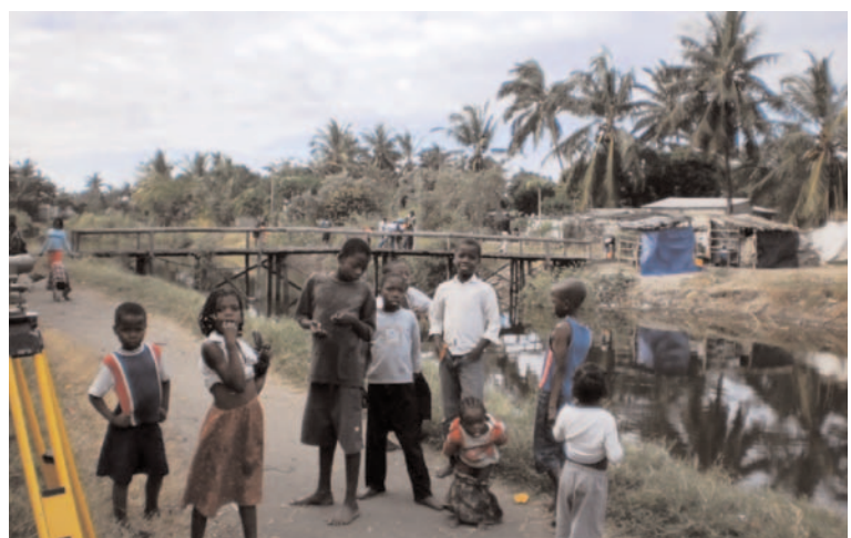
Fig. 9. Trabajos topográficos en los canales de la ciudad de Beira/Surveying work on the channels in Beira.
